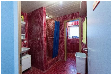
Veraltete, teils schimmelige, undichte und schwierig zu reinigende Nasszellen
